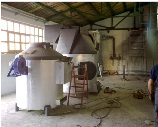
Slika 22. Uređaj za termički tretmkan otpada
